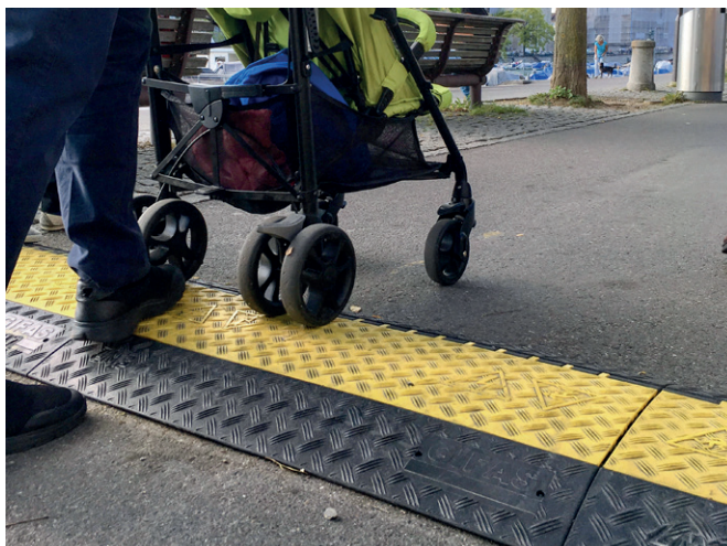
Pont de câble à Zurich
